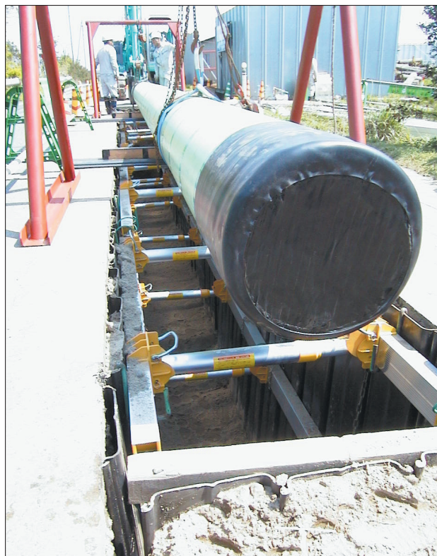
パイプライン工事
