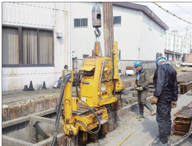
トレンチパイラー(無振動圧入)工法
