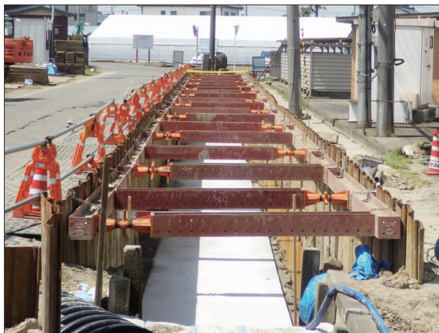
軽量Ⅱ型打込(雨水道幹線)
