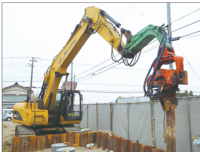
エーパイラー工法
