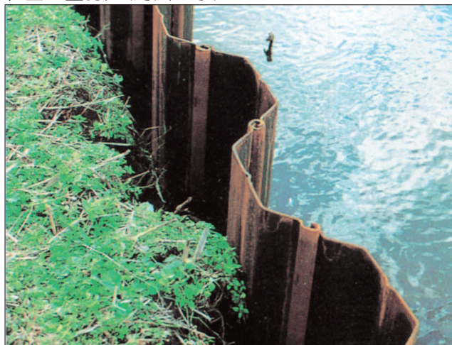
軽量Ⅲ型打込(河川止水)
