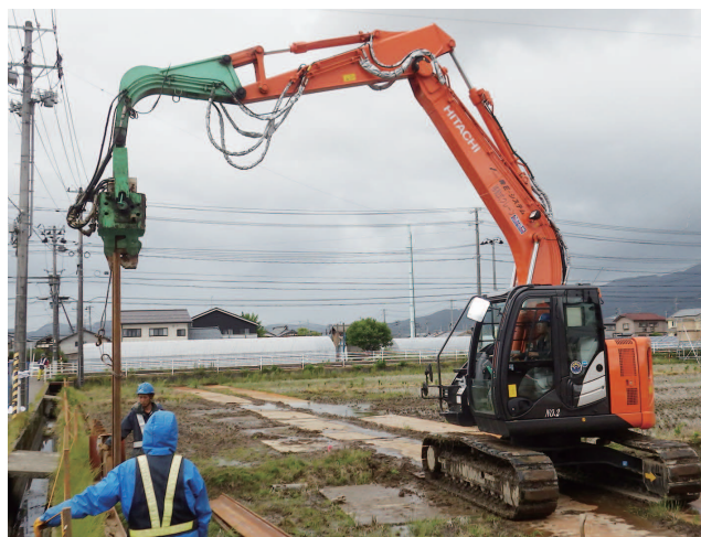
パルソニック(低騒音・低振動)工法
