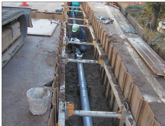
軽量Ⅱ型建込(集落排水)
