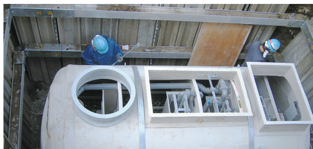
浄化槽埋設工事
